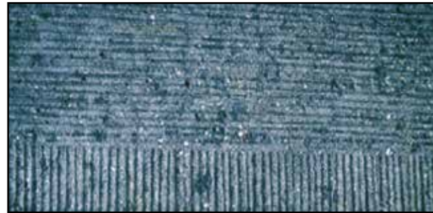
bocciardatura, punzonatura/scalpellatura, fresatura...
