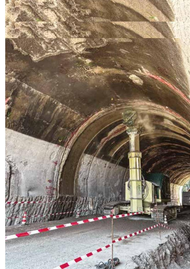
L'asportazione controllata del conglomerato cementizio in galleria si fa a tempo di record grazie alla speciale testata fresante MP 1000HD sviluppata da Simex
