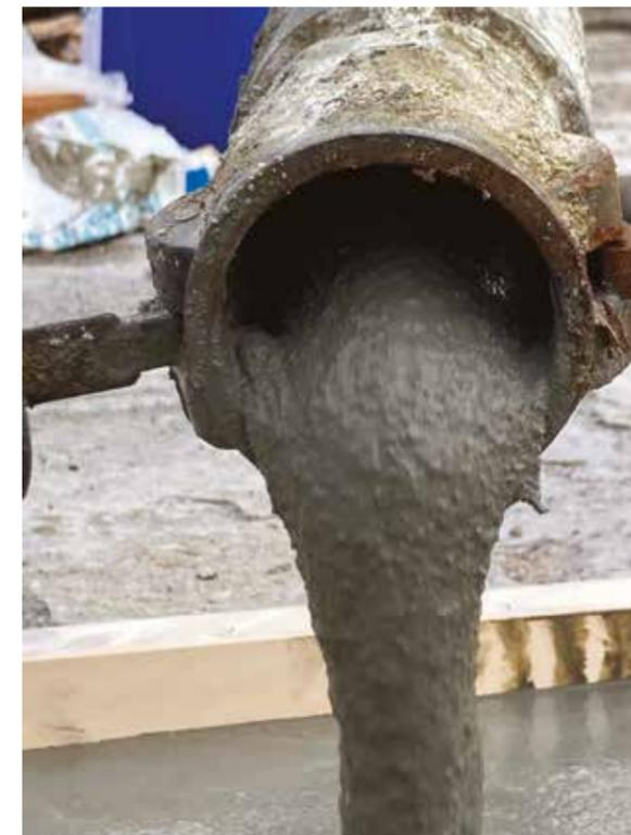
**A REGOLA D'ARTE** Il controllo della qualità degli impasti cementizi prima del pompaggio deve essere sempre seguito, possibilmente anche da parte delle direzioni lavori, dalla verifica della qualità degli stessi impasti dopo il pompaggio, dal controllo del materiale a contatto con la superficie di destinazione ultima e dal monitoraggio dei materiali durante e dopo la completa maturazione.
