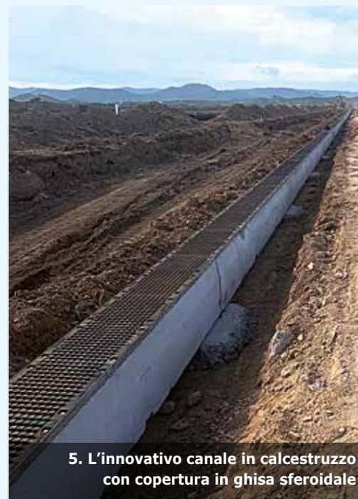
5. L'innovativo canale in calcestruzzo con copertura in ghisa sferoidale
