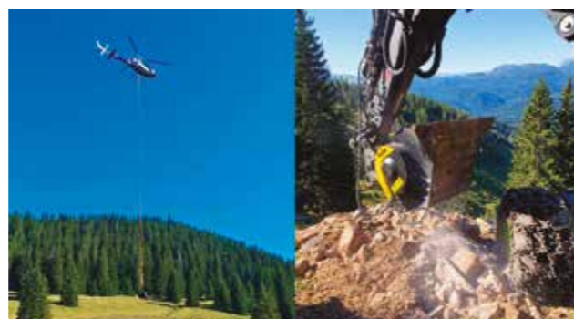
In alto, su Cat 330, la BF90.3 S4 in azione sul Monte Bianco. Sopra la MB-L140 S2 in Valle del Drogo.
