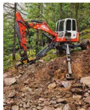
Sopra, la pinza selezionatrice MB-G500 nel cantiere austriaco.
