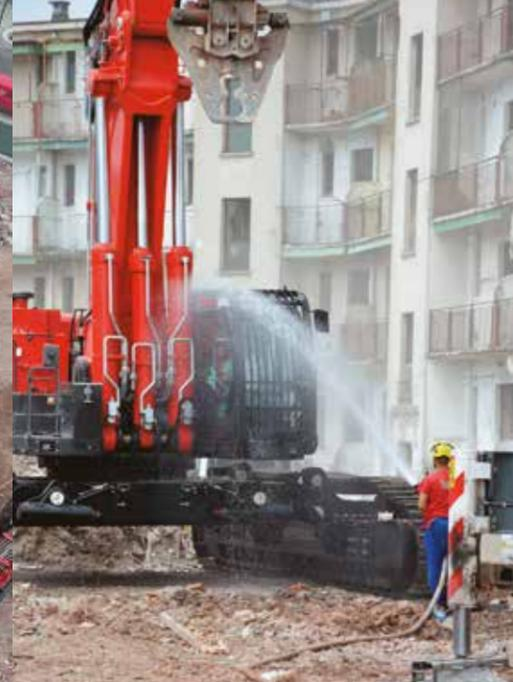
essere montato in due posizioni: una prima in cui il retrofit ha una forma del tutto simile a quella del monolitico standard ed una seconda più "dritta" che permette di eseguire operazioni di demolizione ad altezze moderate, ma con attrezzature molto importanti.
