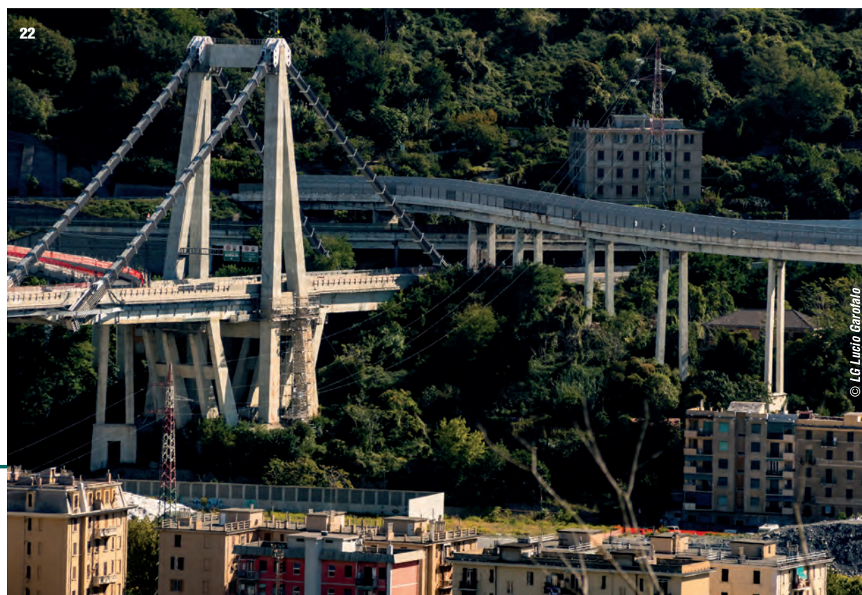
22. La celebre pila 11 dell'ormai demolito viadotto sul Polcevera, a Genova, rinforzata 29 anni fa nell'ambito di un intervento di manutenzione innovativa coordinato dall'ingegner Camomilla, autore di questo articolo, al tempo direttore di un settore unico nel suo genere, che abbinava le Manutenzioni e tutte le loro attività, agli Studi: la DCSM della società Autostrade SpA
