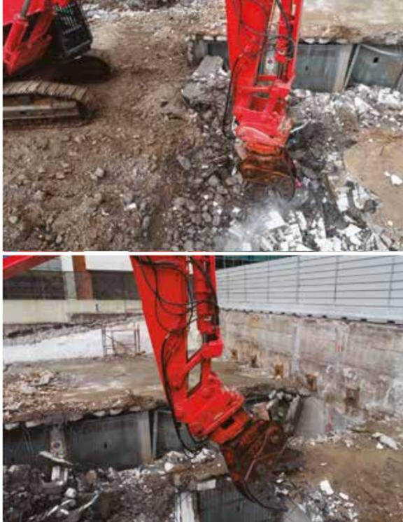
**SOTTOSOPRA** Particolarmente suggestive le due foto in cui si vede l'attrezzatura idraulica che aggredisce il piano terra: ben visibili quelli che una volta erano i box.
