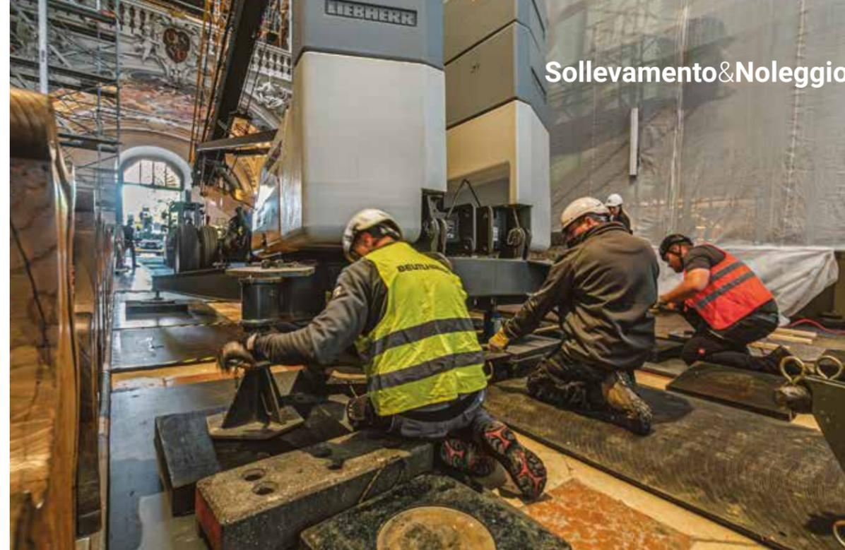
gio e il funzionamento della gru. A questo scopo sono stati prelevati campioni del pavimento, che è stato poi ricoperto prima del montaggio con tappetini antiscivolo e piastre di ferro, per una migliore distribuzione del carico. Sono state utilizzate quattro piastre da 800 kg ciascuna, una per ogni stabilizzatore della gru.
