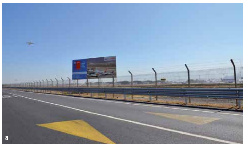
7. Strade e barriere lungo la Ruta 7, nel Sud del Paese (Ruta 7, Ponte Chacano, Regione de Aysén)
